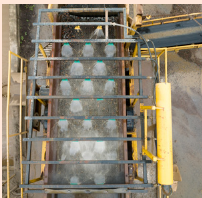
Schaktmassorna siktas och spolat med vatten.
